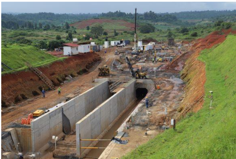
ภาพ: เขื่อนธิบา - Thiba Dam ที่จังหวัด Kirinyaga อยู่ระหว่างการก่อสร้าง (ภาพจาก STARBAG International)
